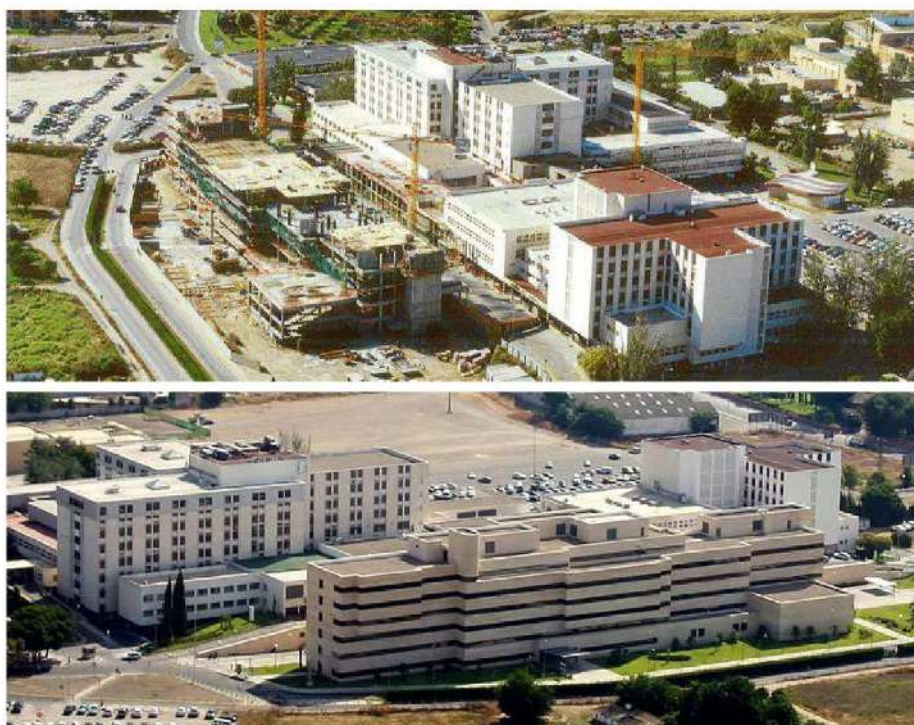
EDIFICIO DE CONSULTAS EXTERNAS 2002
